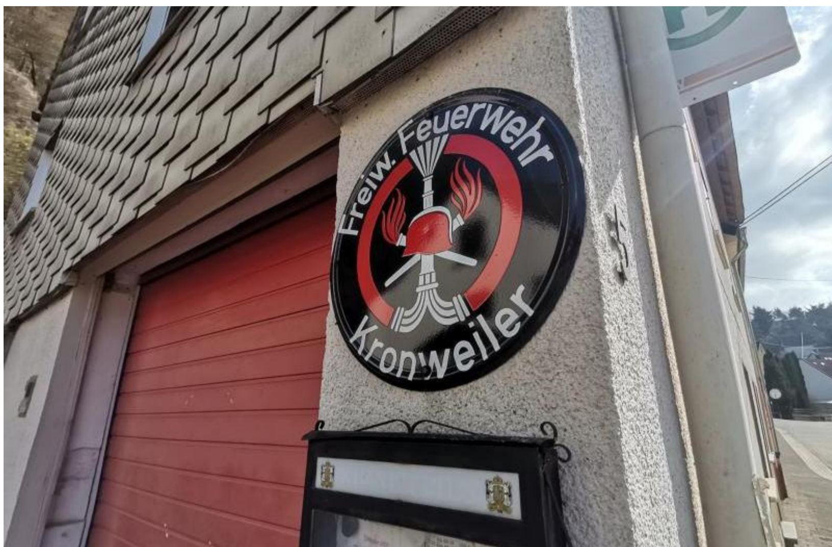
Das Garagentor am Kronweilerer Gerätehaus wird ab dem 1. Juni auch dann geschlossen bleiben, wenn es einen Alarm gibt. Denn die Feuerwehr im Naheort wird ihre Existenz verlieren.
